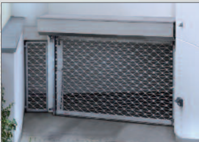
Als Außenroller in einer Tiefgarage – die optimale Lösung bei beengten Platzverhältnissen.
