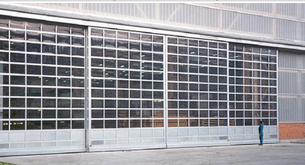
Schiebetor 25 m x 8 m. Stahlkonstruktion mit Alu-Rahmen-Sprossen und Acryl-Doppelverglasung. Bodenfelder mit Alu-Sandwich-Füllung – elektrisch betätigt.
