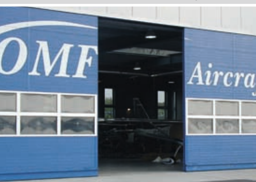
Zweiteiliges Schiebetor mit Aluprofilkonstruktion und elektrischer Bedienung.
