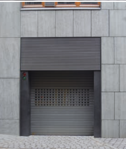
Tiefgaragen-Rolltor mit Auto-Lift und flächenbündiger Lüftungslamellenblende. Automatische Steuerung von Lift und Rolltor.
