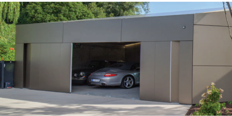
Privathaus Tübingen, Rahmen-Sprossen-Konstruktion mit Alucobond-Bepankung
