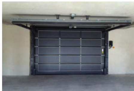
Integrierte Lüftungsfunktion bei am Boden geschlossenem Tor
