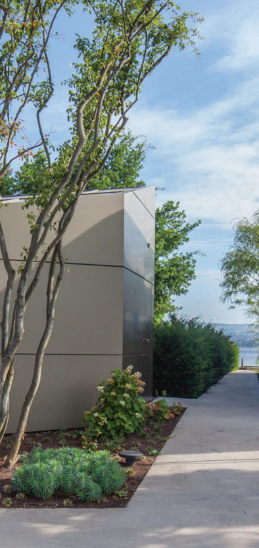
Beplankung unsichtbar befestigt
