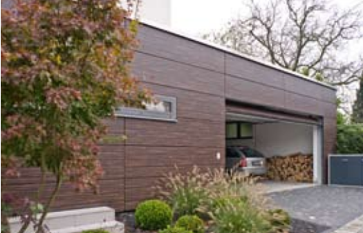
Tor komplett flächenbündig mit Lüftungslamellen und Natursteinfassade - schiefe Ebene
