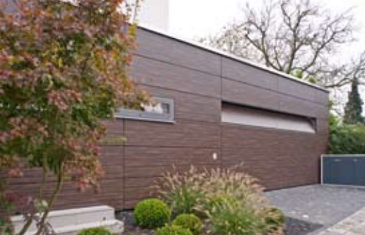
Tor komplett flächenbündig mit Lüftungslamellen und Natursteinfassade - schiefe Ebene
